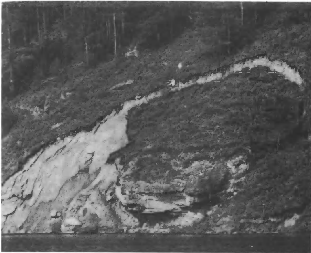
Оползень на берегу Усть-Илимского водохранилища, возникший при его наполнении [июль 1975 г.].
